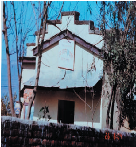
निर्माण अगाडिको स्वास्थ्य चौकी भवन
