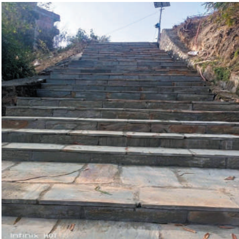
निर्माण सम्पन्न पकाण्डोल पुरानो बस्ती जाने उकालो सिदी निर्माण
